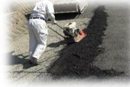
【舗装作業の様子】
