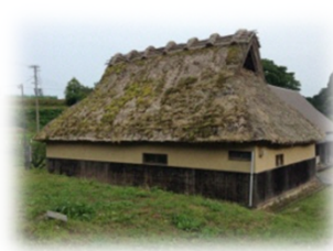
【笹葺き屋根の家】
