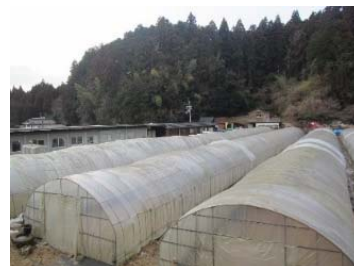
【パイプハウス】
