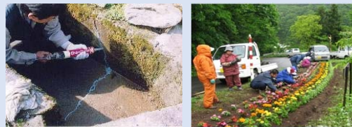
水路のひび割れ補修 植栽活動
