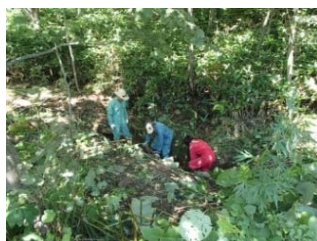
【排水路清掃作業】
