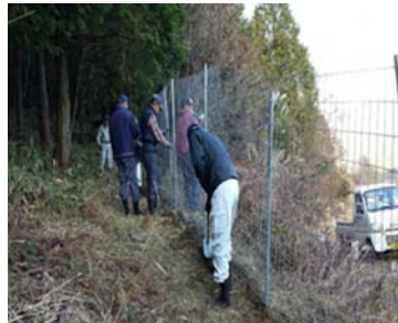
【獣害防止柵の設置】
