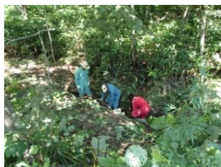
【排水路清掃作業】
