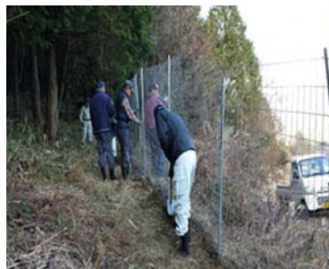
【獣害防止柵の設置】
