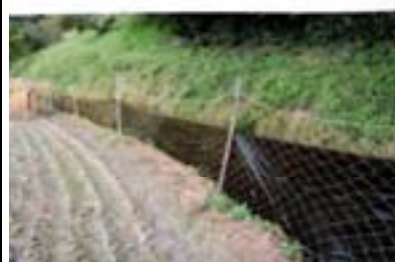
防護ネットの設置
