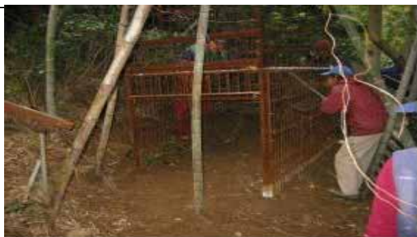
イノシシ捕獲檻の設置作業
