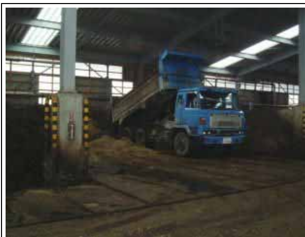
堆肥センター内部（収集されたふん尿、約900 t / 月の収納が可能）
