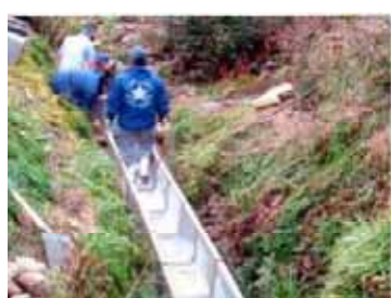
水路補修・改良の様子
