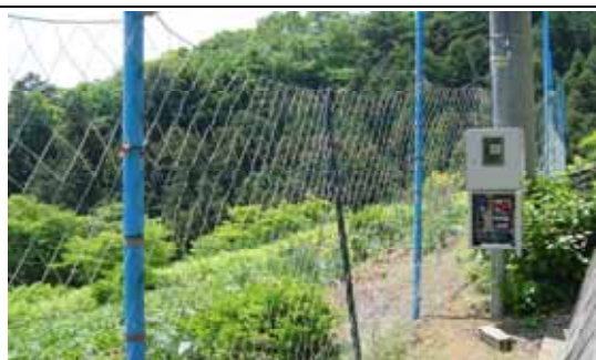
鳥獣害防止のための電気柵の設置
