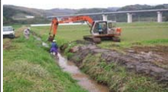
用排水路整備状況
