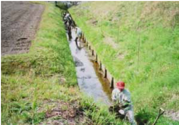
用水路の整備
