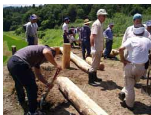
棚田展望台の設置作業
