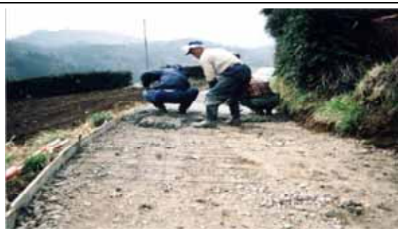
直営施工による農道の整備
