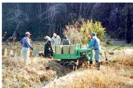
共同作業による水路改修
