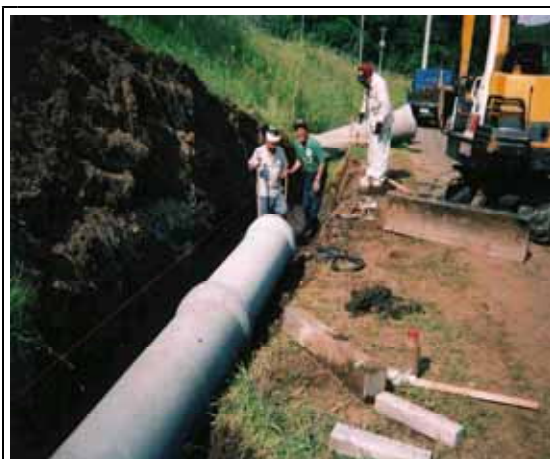
ヒューム管埋設作業
