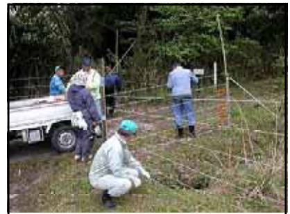
鳥獣害防護柵の設置
