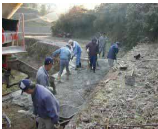
協定参加者による舗装作業
