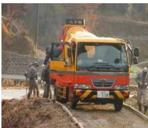
協定参加者による舗装作業
