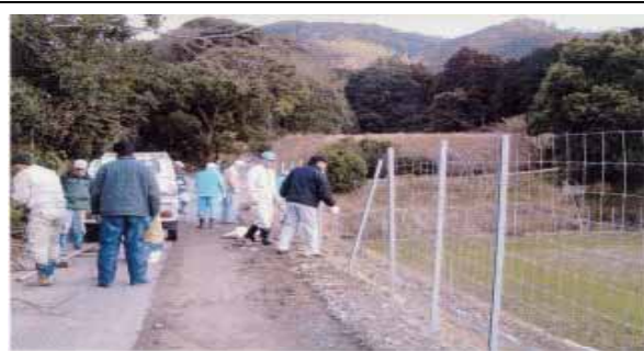
防護柵の補修・設置作業
