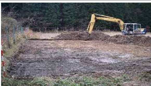
湿田防止工事（表土入替）の実施
