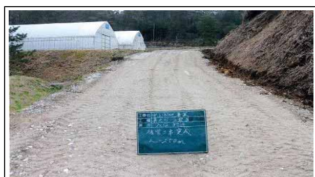
農道の補修状況
