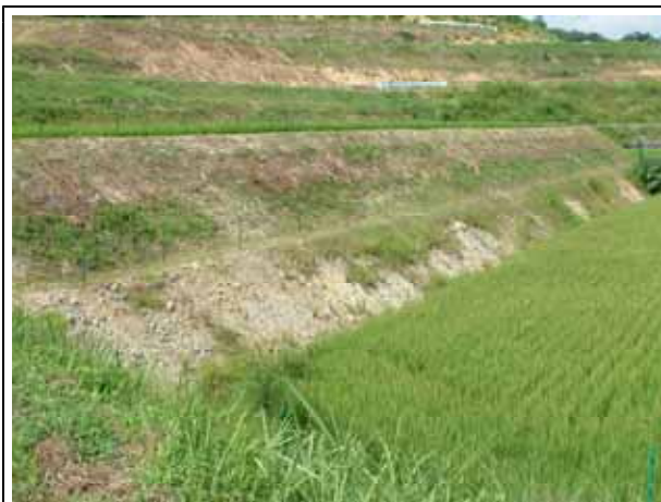
鳥獣防護電気柵の設置状況
