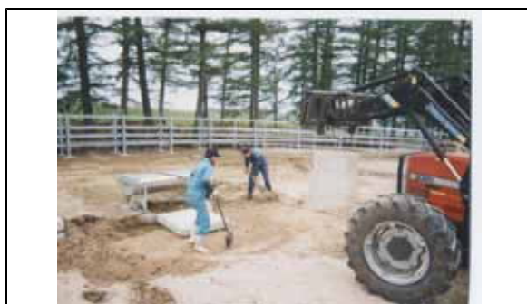
共同牧野追込み柵・給水場の設置作業
