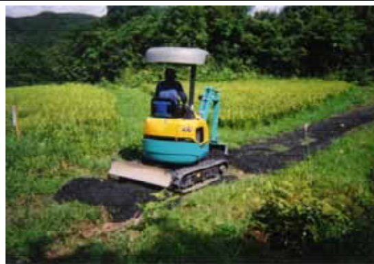
バックホウによる農道整備
