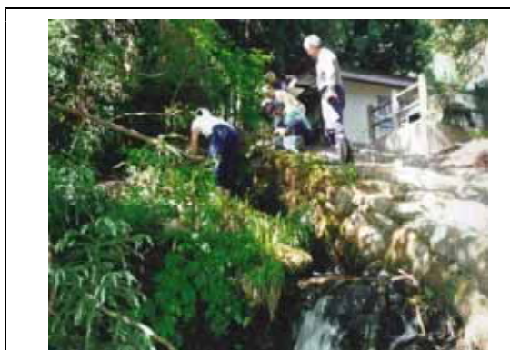
維持・補修の必要な水路の下見調査
