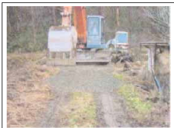
農道の簡易補修（砂利敷き）
