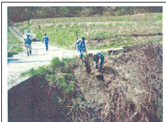
災害復旧工事の様子
