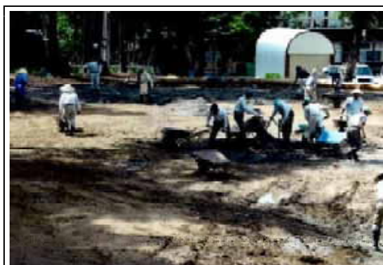
多目的広場の造成
