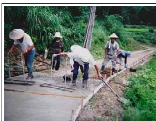
共同作業による農道舗装
