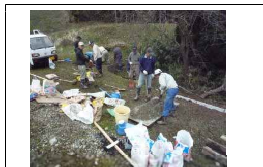
用排水路の改修工事
