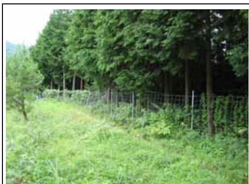
獣害防止フェンスの設置
