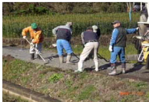
非農家とも協力して行う 農道の舗装作業
