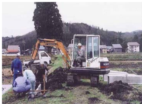
【水路のU字溝設置】
