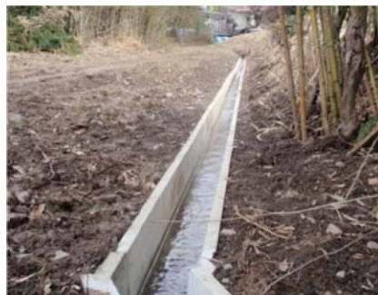
U字溝布設
