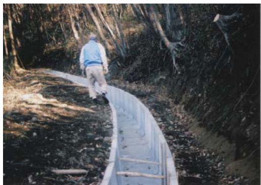
水路の改修状況
