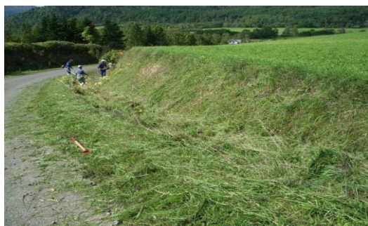
【法面点検と水路清掃】
