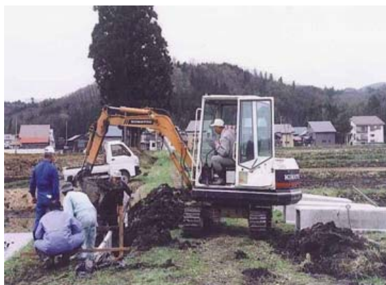
【水路のU字溝設置】
