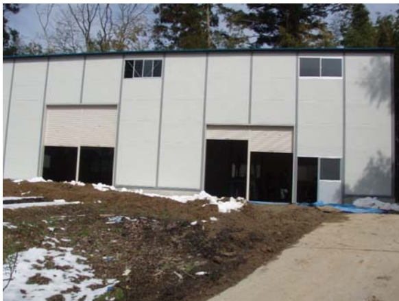
【笠池機械利用組合が所有する乾燥調整施設及び育苗施設】
