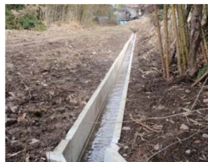
U字溝布設
