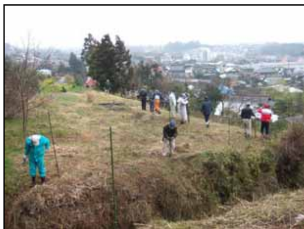
電気柵の設置作業
