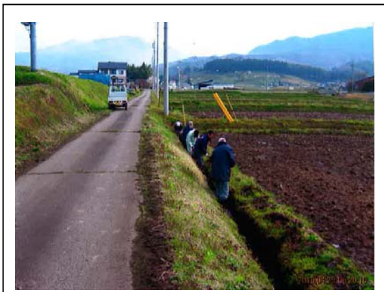
【水路泥上げ作業：春】
