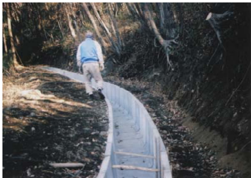
水路の改修状況
