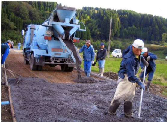
【農道のコンクリート舗装（自己施工）】
