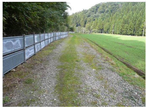
【農道管理状況】
