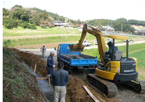
【水路の補修を自己施工にて実施】
