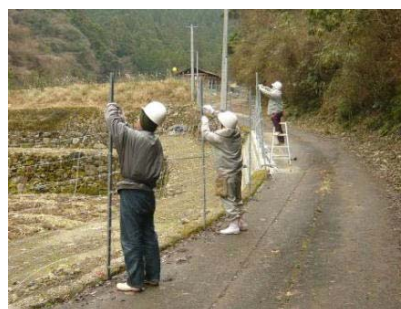
【進入防護柵設置】
