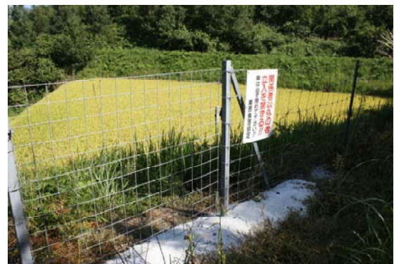
【下からの浸入を防ぐフェンス】
