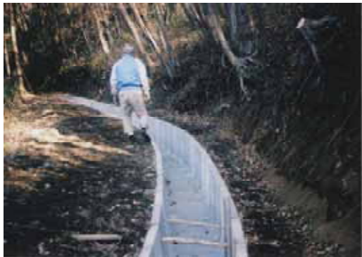
水路の改修状況
