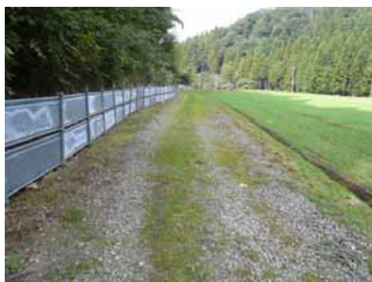
【農道管理状況】
