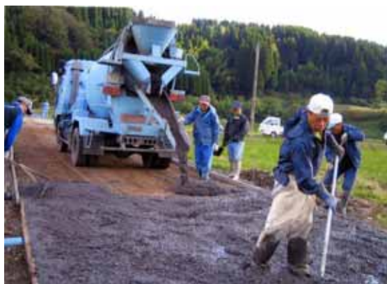
【農道のコンクリート舗装（自己施工）】
