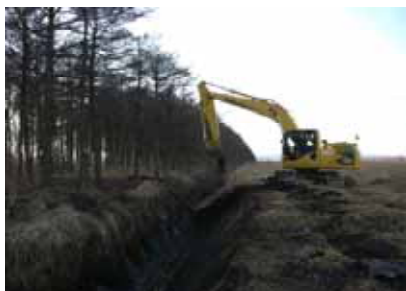
排水路の整備作業
