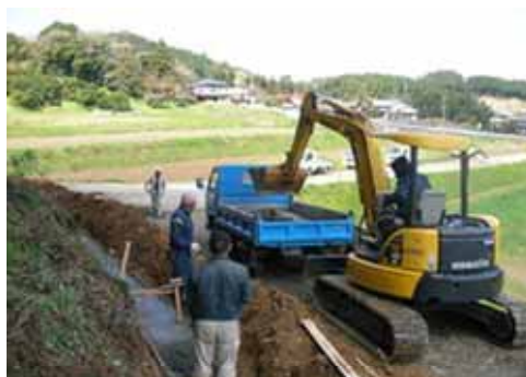
【水路の補修を自己施工にて実施】
