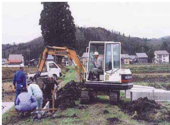
【水路のU字溝設置】
