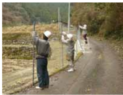
【進入防護柵設置】
