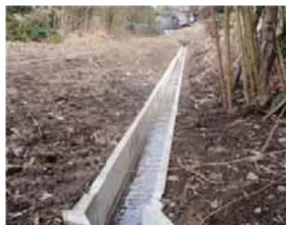
U字溝布設
