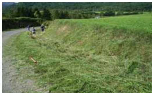
【法面点検と水路清掃】
