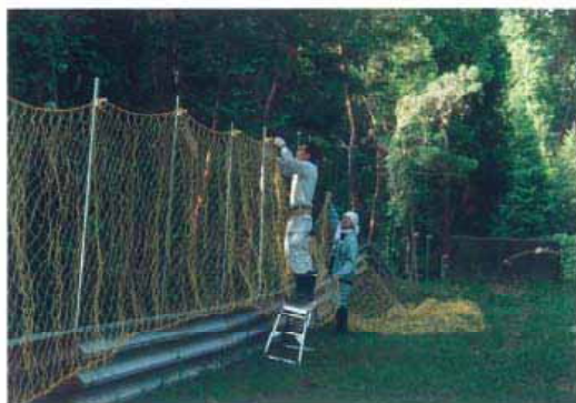
獣害防止柵の設置と補修
