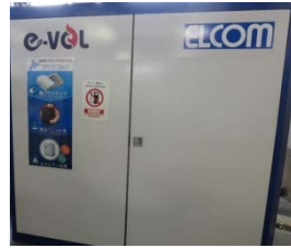
ペレット燃料用ハイブリッドボイラー 高さ2m×幅1.8m×奥行1.4m
