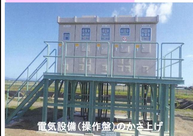
電気設備(操作盤)のかさ上げ
