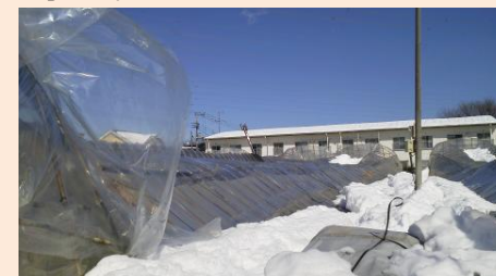
雪で倒壊した日野市のトマトハウス
