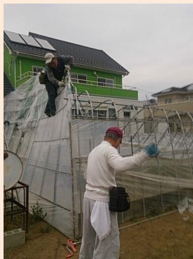
支援隊による撤去作業
