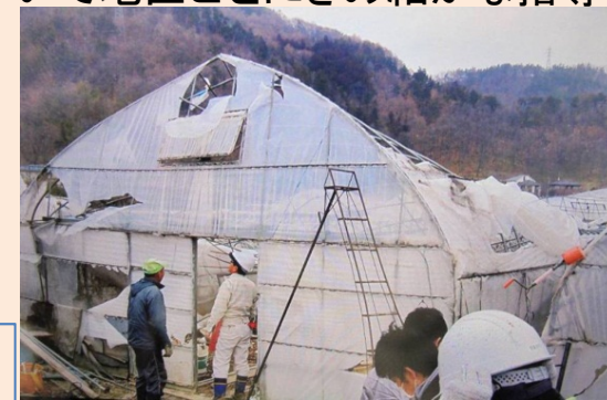
倒壊したハウスの撤去を支援した。
