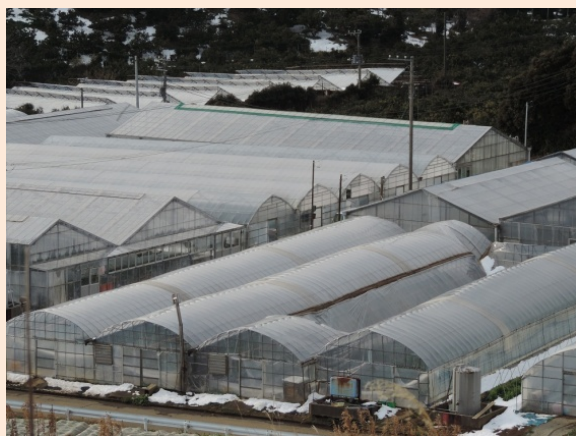
ビニールハウスの被害状況
