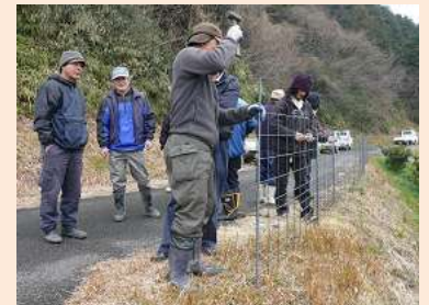
侵入防止柵の設置
