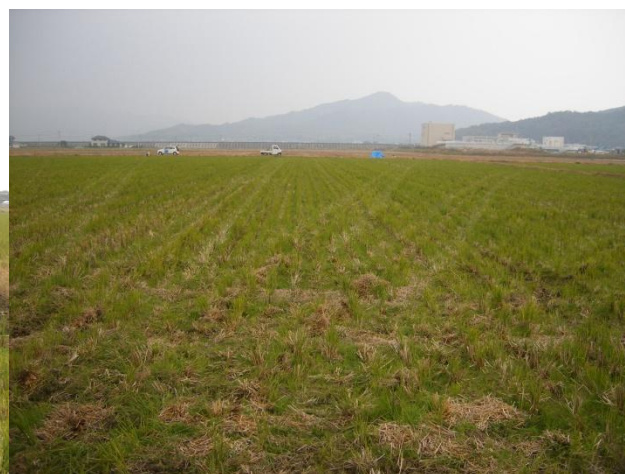
写真3 放射状弾丸暗渠の施工跡
