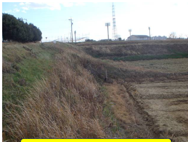
傾斜のきついほ場出入口
