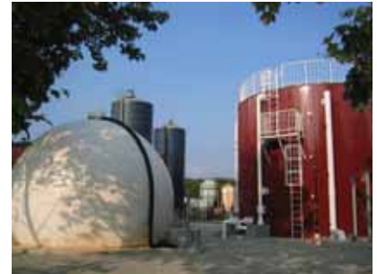
バイオガスプラント
