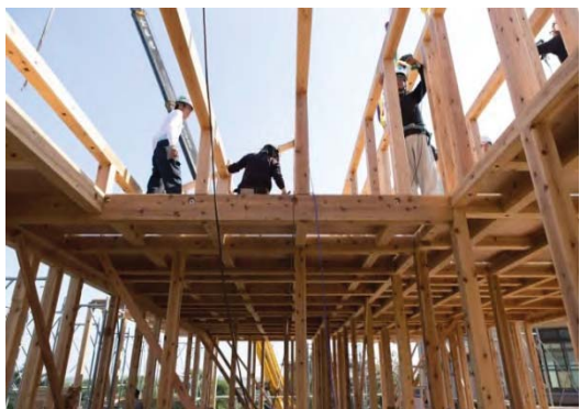
木造住宅の建築状況
