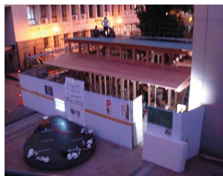
県産材ショールーム
