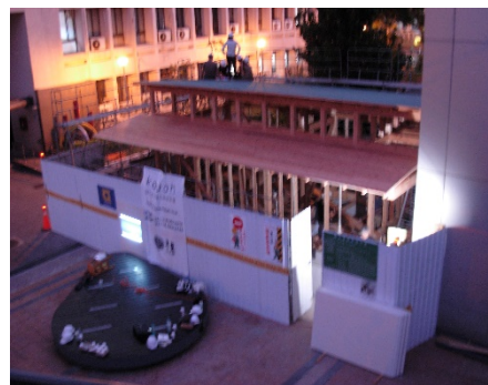
県産材ショールーム
