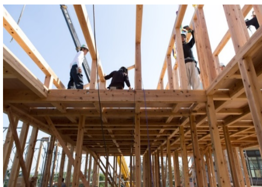
木造住宅の建築状況
