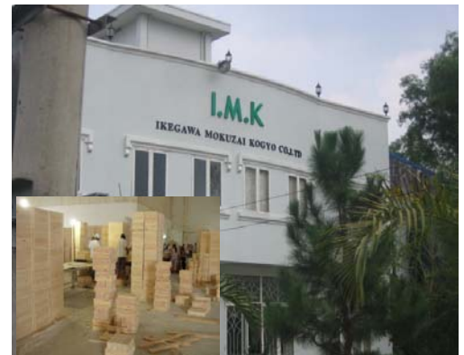
ベトナム工場とその内部
