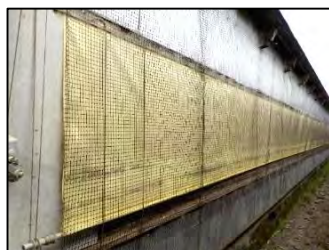
〔防鳥ネットの設置〕
