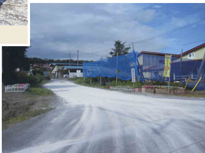
消石灰帯の設置
