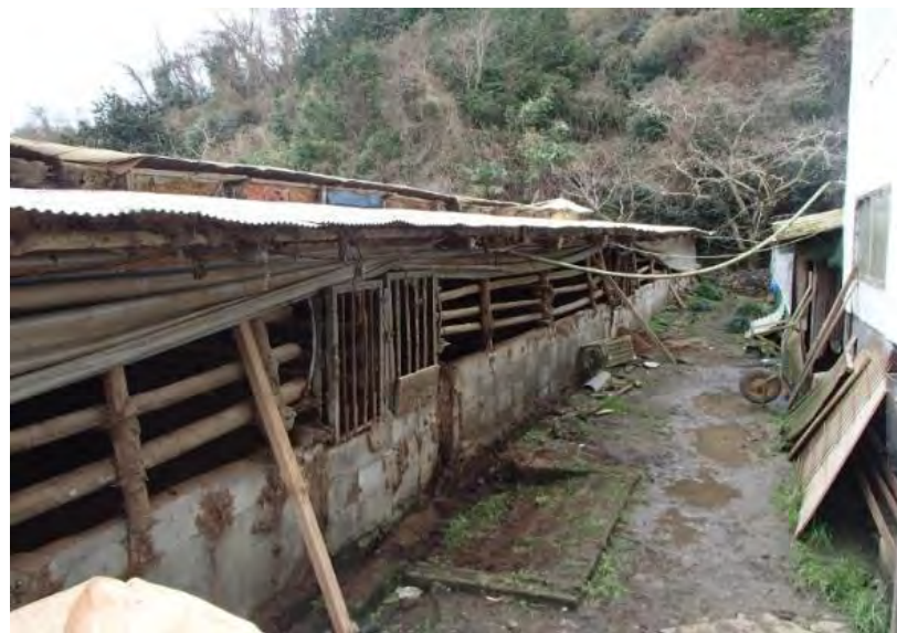
発生豚舎外観。防鳥ネット等の設置なし。
