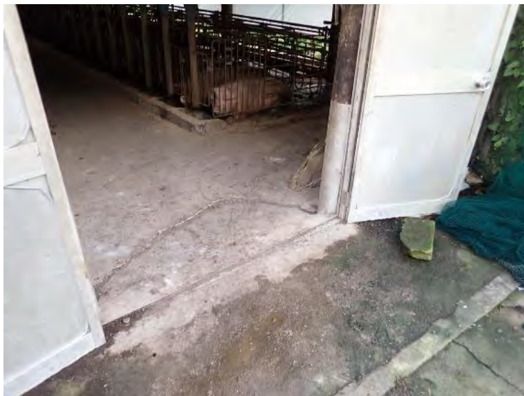
豚舎入口。消毒槽、豚舎専用長靴なし
