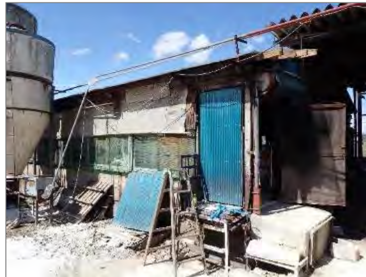
発生豚舎（離乳舎）外観。長靴交換や靴底消毒の実施なし。
