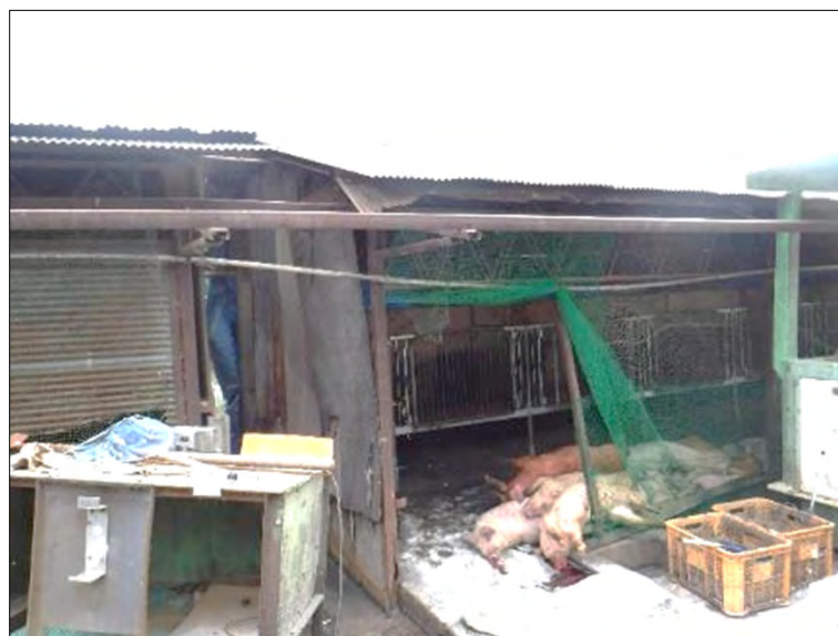
発生豚舎外観：靴底消毒は実施していたが、長靴及び作業着の交換の実施なし。
