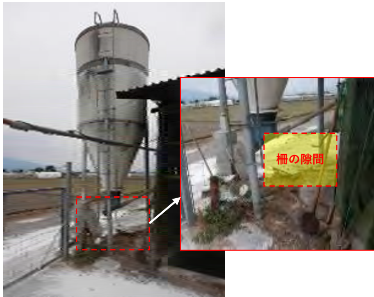
障害物により柵が設置ない箇所があるため隙間あり。
