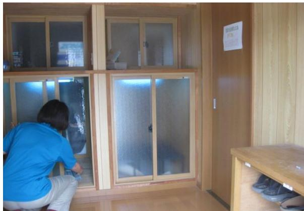
既存の棚に紫外線殺菌灯を設置し、パスボックスに改造した事例【豚農場】※衛生管理区域に持ち込む文書ファイル及びメガネ等の殺菌に使用
