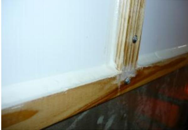
壁面の角をコーティングして清掃しやすくした事例【豚農場】
