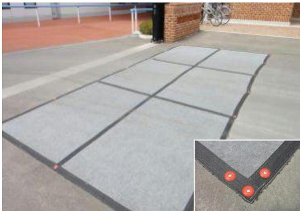
消毒マットの設置事例【競馬場】※アスファルトへの鉄釘固定
