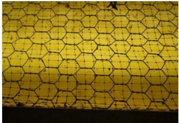
開口径3cmの金網に防鳥ネット（開口径1.5cm）を設置した事例【鶏農場】※ネットは強度があり、鼠の侵入も防除
