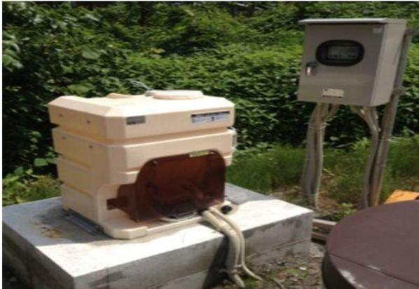
飲水消毒装置の設置事例【牛農場】※次亜塩素酸の添加による消毒
