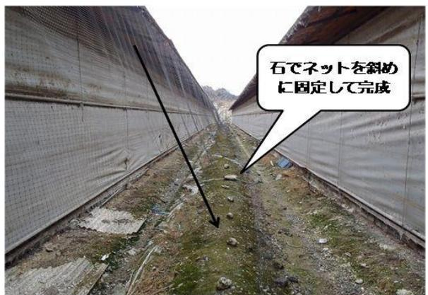
雨による埃除去を狙い防鳥ネットの斜めに設置した事例【鶏農場】※非積雪地域での設置
